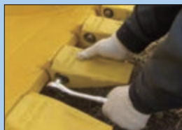
Coloque o casquilho, a arruela e os parafusos e aperte com uma chave de catraca
