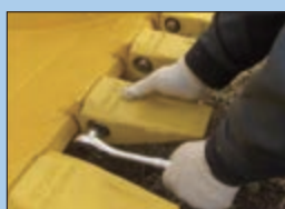
Placer la bague, la rondelle et le boulon. Serrer avec une clé à douille
